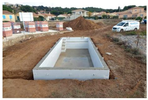
Les murs en blocs de polystyrène SolidBric sont rapides à monter et nécessitent peu de réservations.
