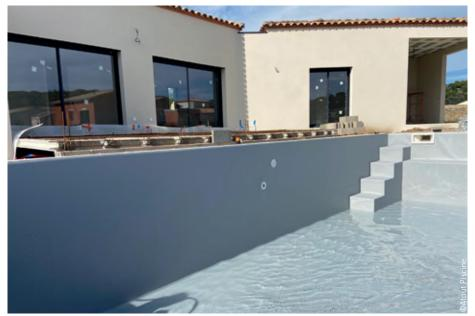
La membrane armée est posée sur place pour épouser les particularités du bassin. La mise en eau a été réalisée avant même le coulage de la première terrasse.
